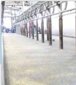
ARMOR-ROCK™ Restores Old Parlor
